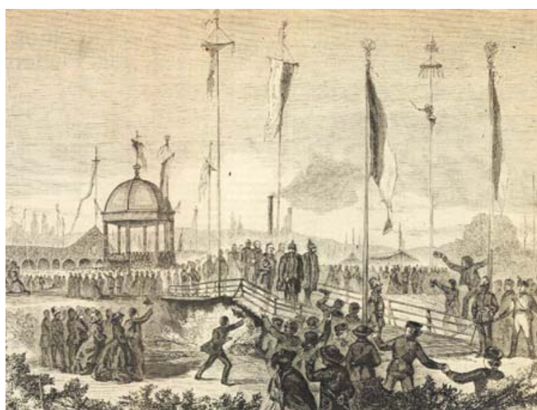
Auf dem Rennfeld wurde die Eisenbahn-Einweihung am 3. Juli 1861 zwei Tage lang gefeiert. Für Großherzog Friedrich I. (mit Pickelhaube, beim Überschreiten der Nagold) war ein Pavillon aufgebaut, um das bunte Treiben zu verfolgen.
